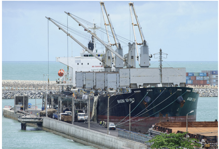
Port de Cotonou : déchargement de charbon pour production d'électricité locale et livraison vers le Niger par camion.
